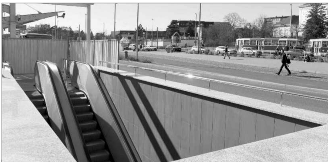
Pražský dopravní podnik zprovozní 13. dubna chybějící eskalátory v podchodu stanice metra A Nádraží Veveslavín. Pohyblivé schody jsou zabudovány do současného pevného schodiště vedoucího k autobusovému terminálu. Chybějící eskalátor byl často terčem kritiky, od stanice totiž jezdí autobusy MHD na letiště. FOTO - ČTK/ Ondřej DEML
